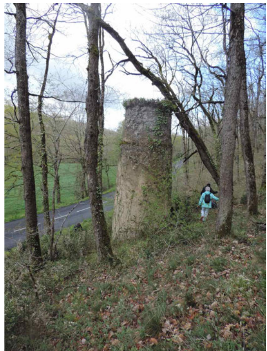
Photo du puits d'aération
